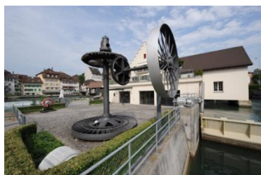
Jonvalturbine mit dem grossen Kammrad, geliefert von Escher-Wyss 1875 (vor der Renovation)
