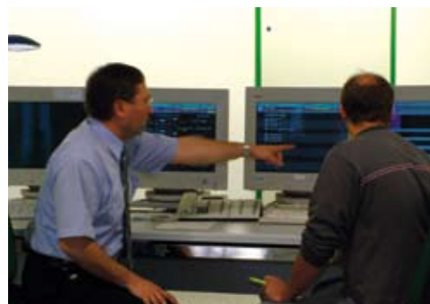
Zentrale Netzleitstelle Aarau
