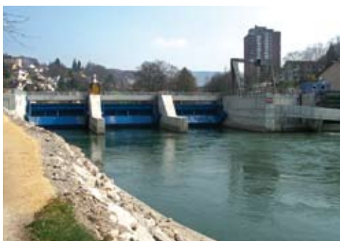
Wasserkraftwerk Kappelerhof Baden
