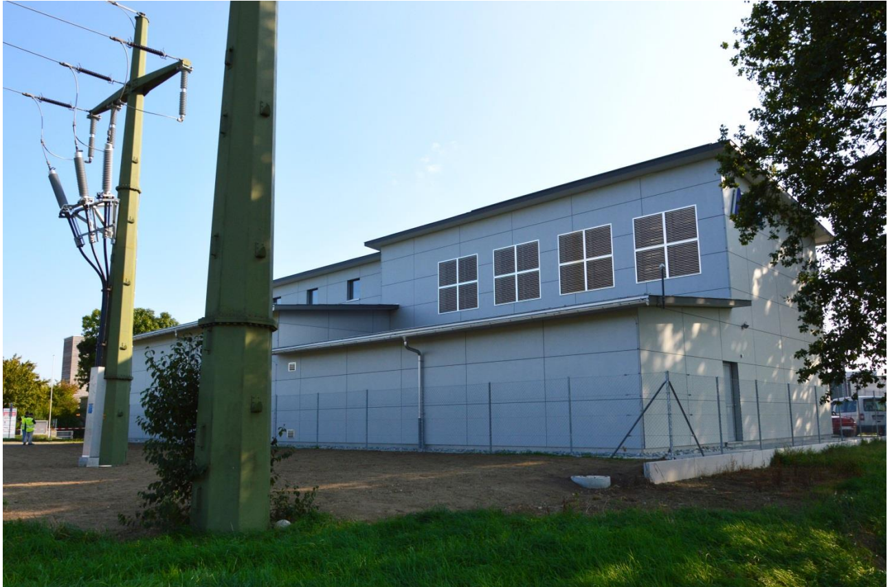
Abbildung 1: Das neue Unterwerk Wohlen
