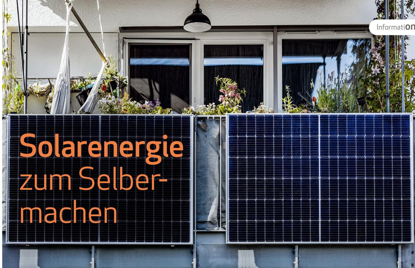
Plug-&-Play-Solaranlagen sind steckfertige Mini-Photovoltaik-Kleinanlagen, die ohne Fachwissen installiert werden können und den Strom direkt in eine Steckdose einspeisen.
