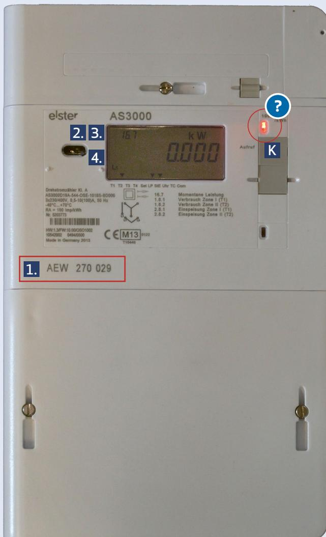
**Info:** Das rote LED-Lämpchen blinkt nach jeder verbrauchten Wattstunde auf. Leuchtet das Lämpchen konstant, wird in diesem Moment kein Strom verbraucht.
