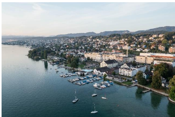
Seebad Kilchberg und Gebäude der Lindt & Sprüngli (zvg)
