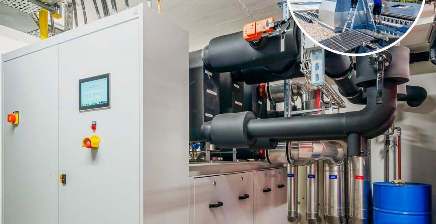
Beim Freecooling werden natürliche Kältequellen genutzt – Grundwasser beispielsweise. Damit können Räume oder Anlagen gekühlt werden, ohne auf energieintensive Kühlprozesse zurückzugreifen. In Kombination mit einer Grundwasser-Wärmepumpe lässt sich die Temperatur in einem Gebäude ganzjährig effizient und kostengünstig regulieren.
