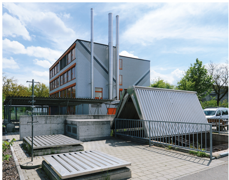
Der Eingang zur Wärmezentrale im Schulhaus Isenlauf, rechts im Bild ist das Schnitzelsilo zu sehen
