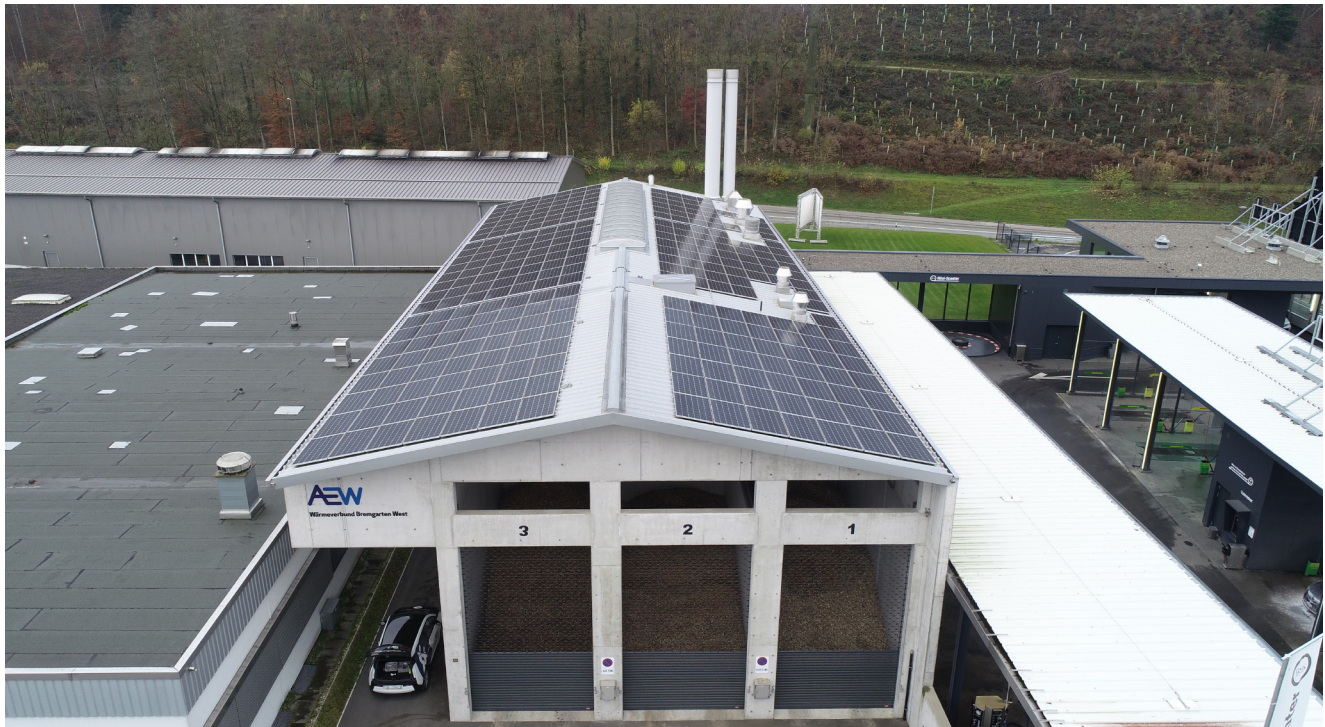
Die Wärmezentrale Bremgarten West mit Photovoltaik-Anlage
