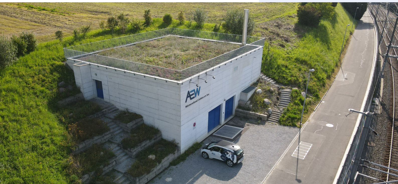
Die Heizzentrale in Uetikon am See
